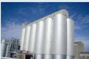
サイロで乾燥した籾を保管し温度や湿度を管理します。
